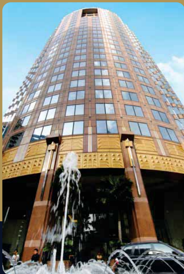
MENARA HLA 3 Jalan Kia Peng 50450 Kuala Lumpur
